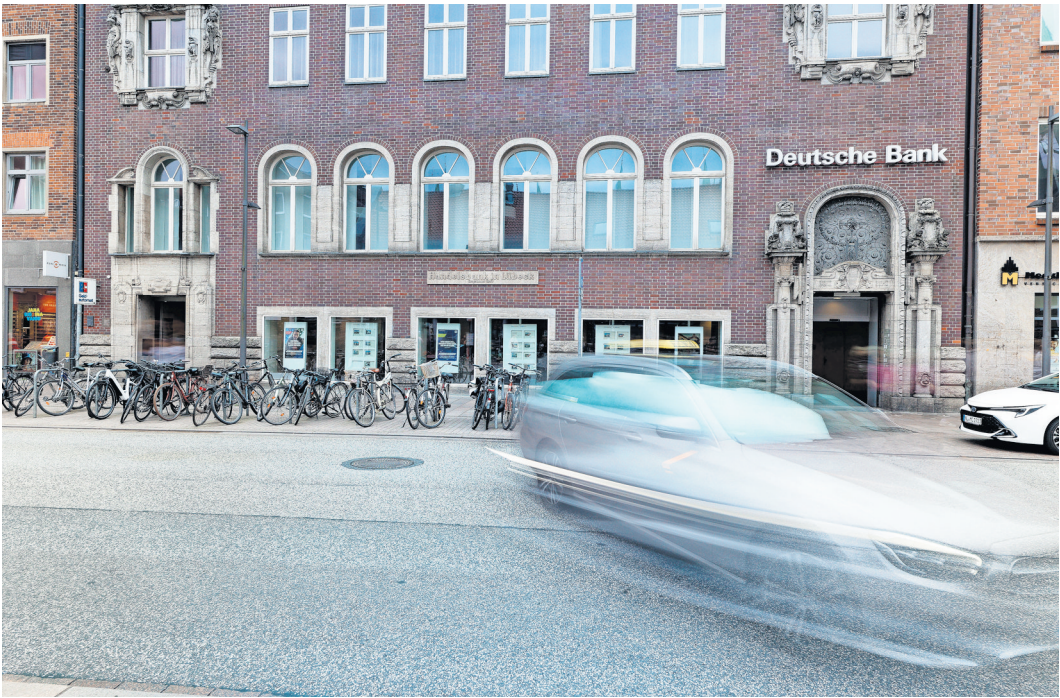
Wie gut war die Bank gesichert? Nach dem Einbruch bei der Deutschen Bank in Lübeck laufen die Ermittlungen der Lübecker Staatsanwaltschaft weiter. FOTO: LUTZ ROEBLER
