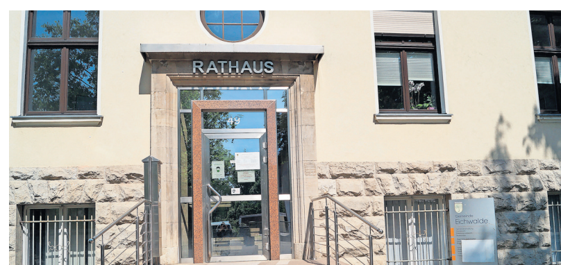
Da im Rathaus Eichwalde vergessen wurde, einen Beschluss der Gemeindevertreter umzusetzen, stehen jetzt Nachzahlungen an. FOTO: HEIDRUN VOIGT
